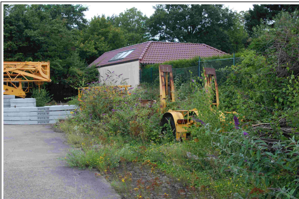
Befestigungsflächen mit Vegetationsentwicklung Biotoptyp 2.6.2, sowie rechts anschließender Böschungsbereich mit Grasfluren (verdeckt) und im Hintergrund Gehölzstreifen Biotoptyp 8.10.1, Blick nach Nordwesten am Rand des Geltungsbereiches
