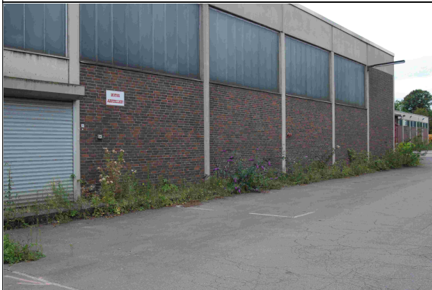
Kiesstreifen am Mauerfuß mit Vegetationsentwicklung im Nordosten
