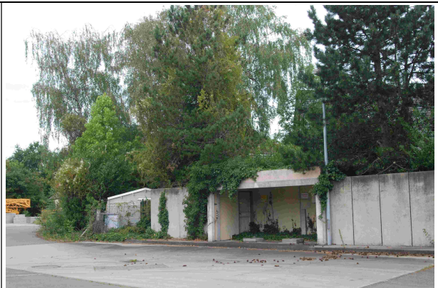
Ehemalige Betriebstankstelle, offene, überdachte Einhausung der bereits entfernten Zapfsäulen. Glatte Innenwände ohne Spaltenverstecke.
