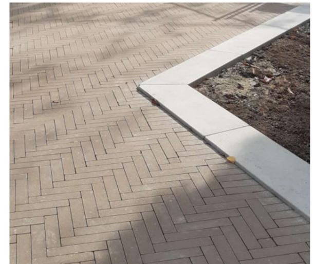
Betonsteinpflaster im Klinkerformat
