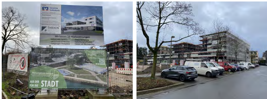
Abbildung 11: Baustelle für das Agatha-Quartier am Vosskamp
