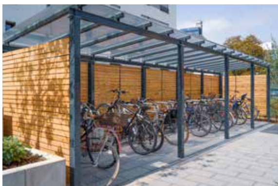
Offene, überdachte Abstellanlage vor einem Wohnhaus, Foto: projekt w – Systeme aus Stahl GmbH
