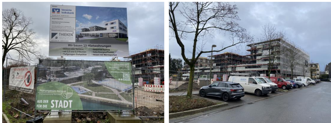
Abbildung 11: Baustelle für das Agatha-Quartier am Vosskamp
