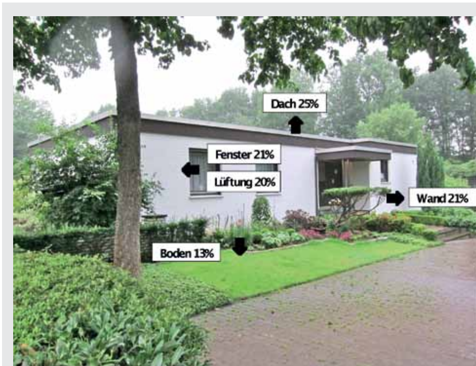
Bild 1 7: Wärmeverluste Einfamilienhaus Quelle: Gertec
